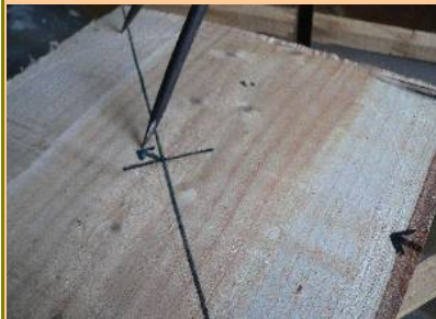
Le cercle est hors- champ et se trouve dans l'écorce si l'on utilise le centrage des diagonales. Il est nécessaire de faire un décalage radial.
